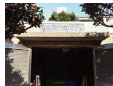
（日暮里南公園 給水槽） 1,500立法ℓ
